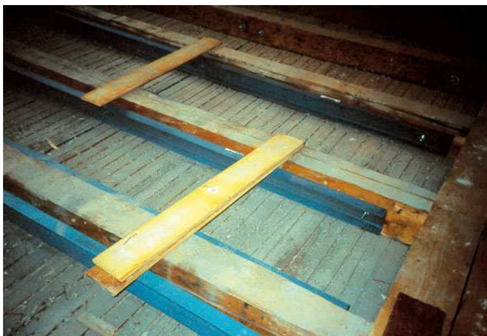
Obr. 7 Použitie oceľových príložiek [05]
