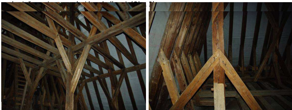
Obr. 3) Krov nad severnou kaplnkou
