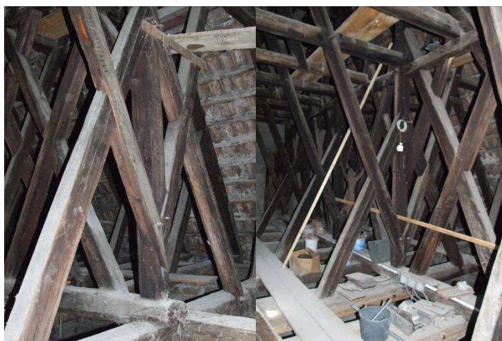
Obr. 4) Krov nad svätýňou
