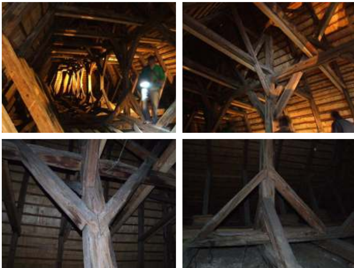
Obr. 2,3,4,5 Pohľad do krovu a na konštrukčný detail
